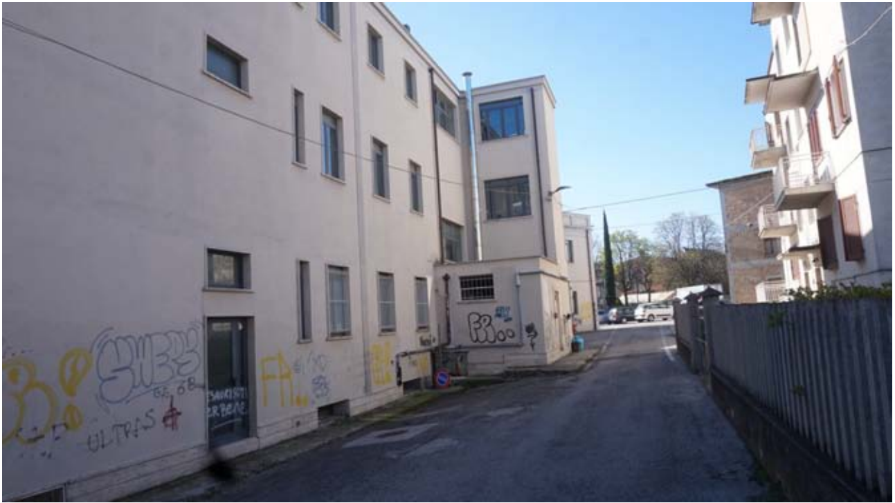
Vista lato ovest
